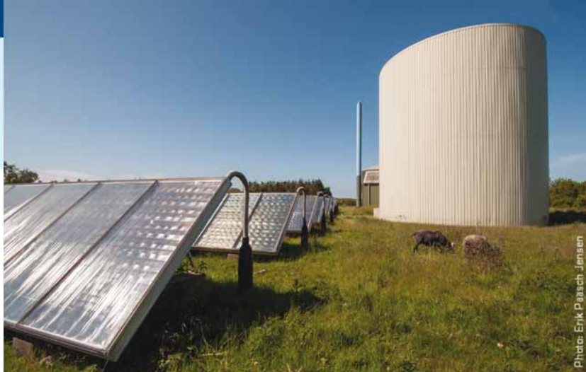
Zonnecollectoren en warmtetank voor het warmtenet in Nordby (foto Erik Paasch Jensen, Energiakademiet Samsø)
