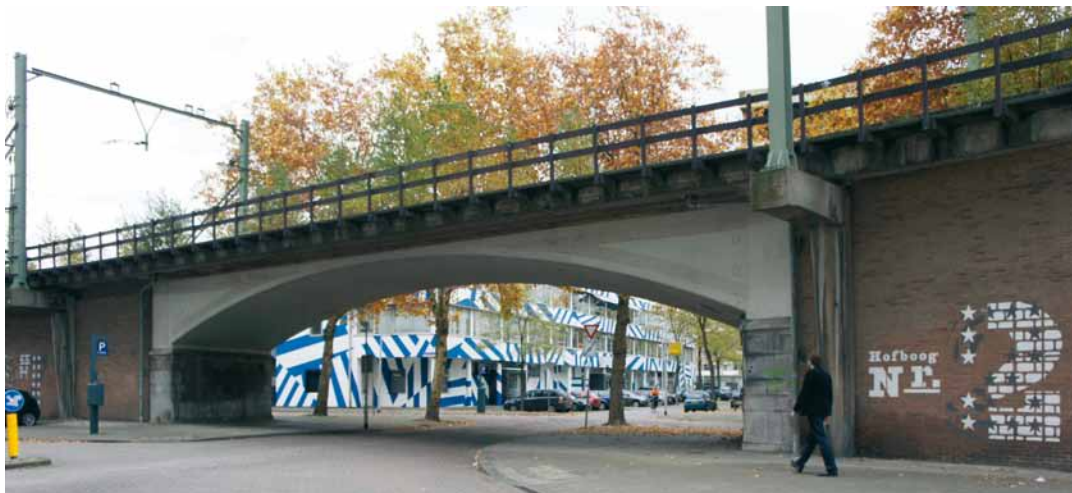
Figuur 5 De Hofpleinlijn ter hoogte van de Zomerhofstraat.
