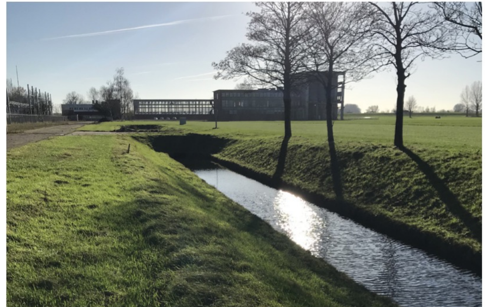
Afb. 26 Over het terrein liep een waterontwateringsmet deuren van een pompeiland. De pompen
