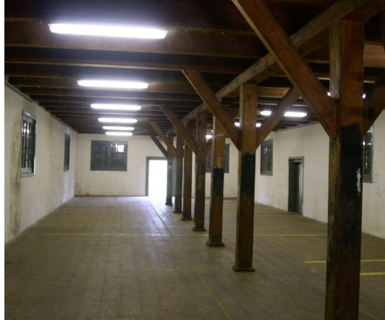
37. Het interieur van magazijn 3 met een forse houten constructie en een ruime zolder.
