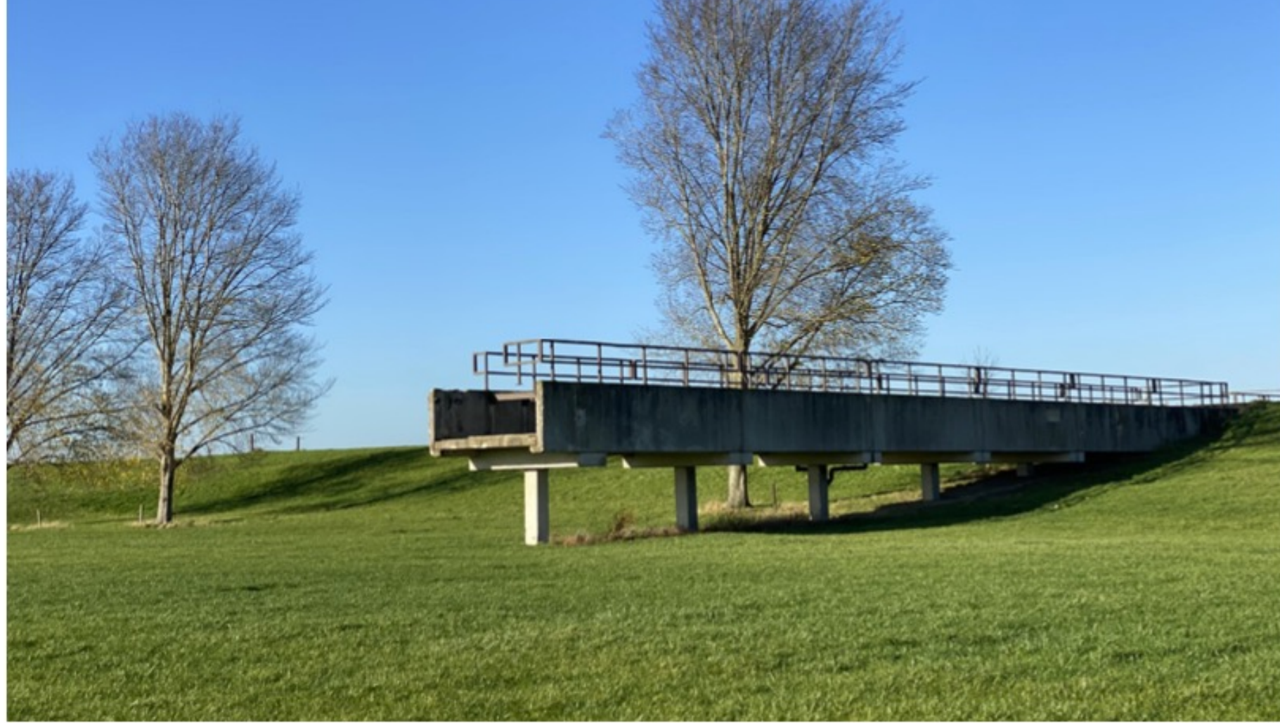
Afb. 23 Deel van de betonnen leidingbrug die van de oliesteiger naar het tankenpark liep.
