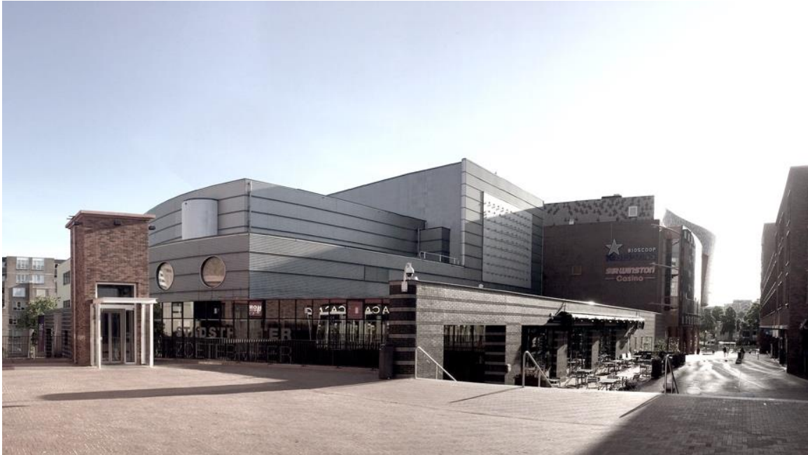
Afbeelding 9: Huidige situatie projectlocatie
