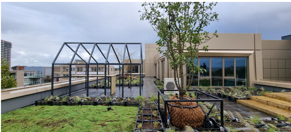
Afbeelding 5: Het pilot-dak in aanbouw
